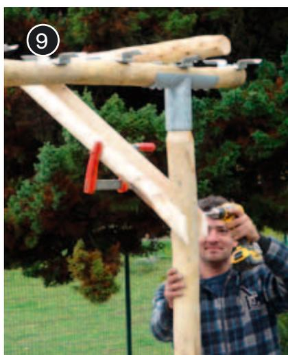
**9** Mit einer Schraubzwinde werden die Diagonalstreben im 45 Grad Winkel von Pfosten zu Pfetten positioniert und mit 14 mm Bohrer vorgebohrt. Die Eckverbindung ist an den Pfosten mit 12 x 200 mm an den Sparren mit 12 x 165 mm Schrauben zu befestigen. Jetzt kann der fertige Rahmen ausgerichtet werden.
