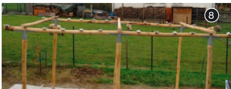
**8** Die 3 Sparren über den senkrecht stehenden Pfosten werden aufgelegt und verschraubt. Schrauben 8 x 30 mm.
