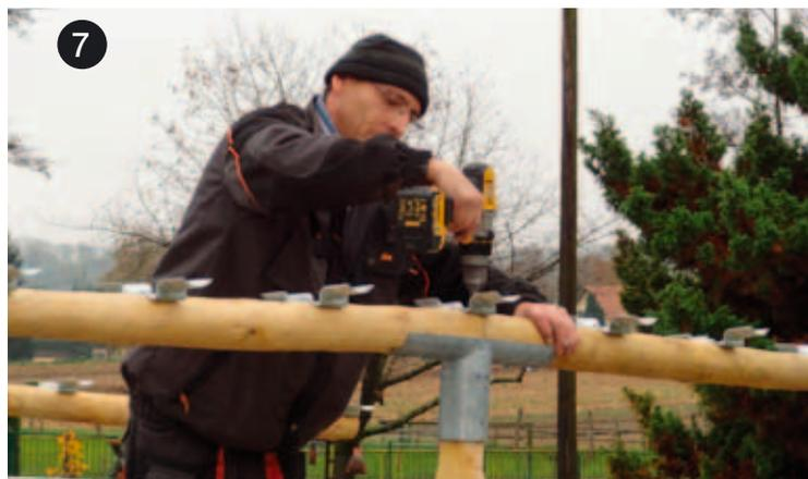
**7** Die zwei letzten Holzverbinder über den Pfosten aufschrauben. Die Schraube sollte im Holz sitzen, eventuell leicht schräg eindrehen. Schrauben 8x30 mm.
