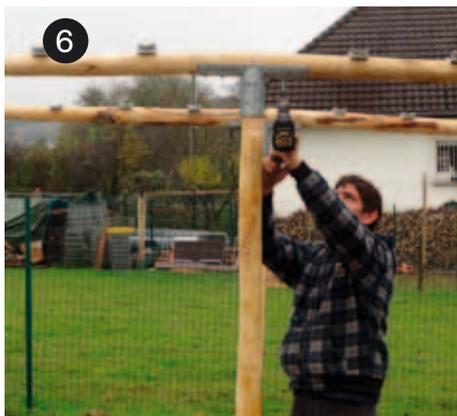
**6** Nun werden die 4 Pfetten über den senkrecht stehenden Pfosten aufgelegt und verschraubt. Schrauben 8x50 mm.
